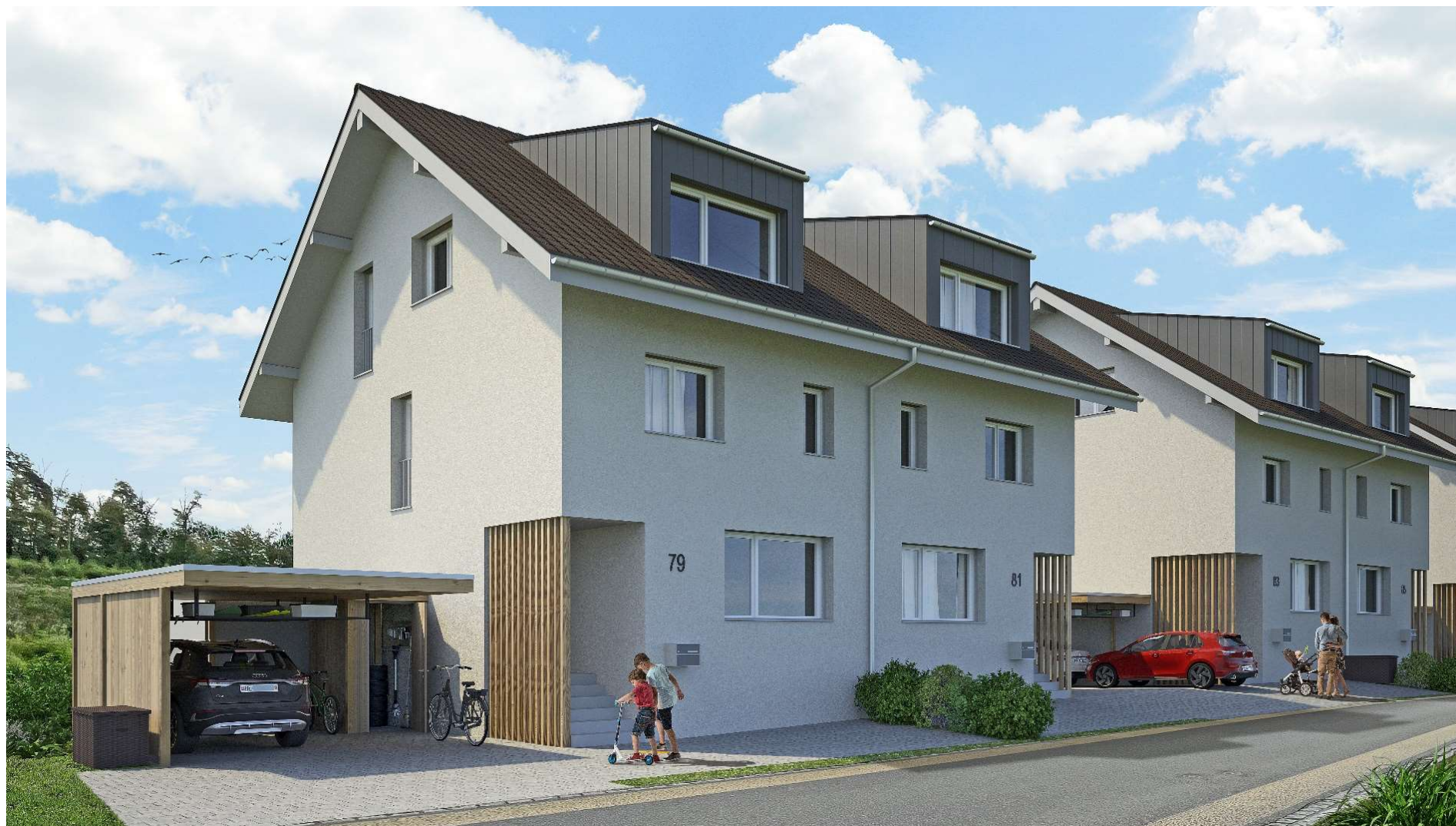
Neubau 3 Doppelfamilienhäuser, Länggasse, 3292 Buswil Gemeinde Lyss/Buswil
